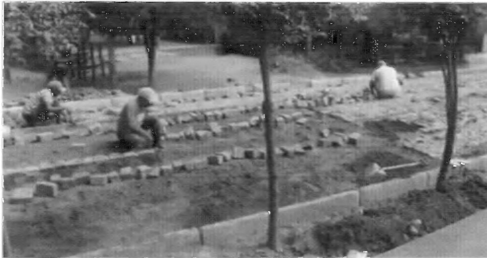
Obra sendo executada
